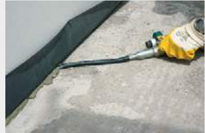
Maschinelles Verfüllen der Bauteilfuge
