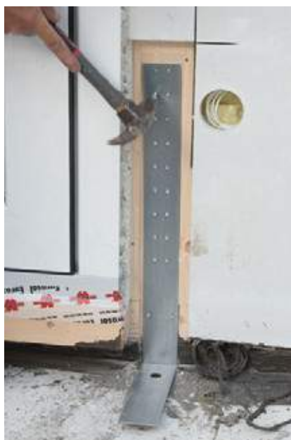
Montage Zuganker (Verdübelung Lastplatte noch nicht erfolgt)
