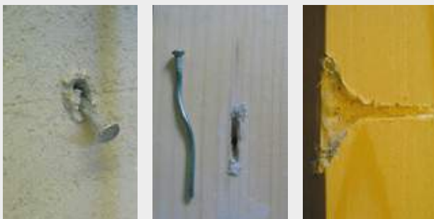
Plastische Verformung und Lochaufweitung nach der zyklisch-dynamischen Beanspruchung der Konstruktion. fermacell® Gipsfaser-Platten (links), Holzunterkonstruktion mit verformtem Verbindungsmittel (Mitte), Schnitt durch Holzunterkonstruktion (rechts)
