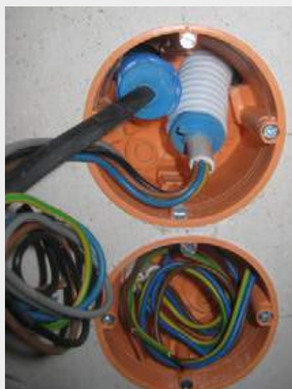
Beispiel: Abdichten der Leerrohre, die nach außen führen
