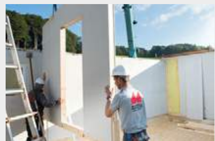
Montage auf der Baustelle
