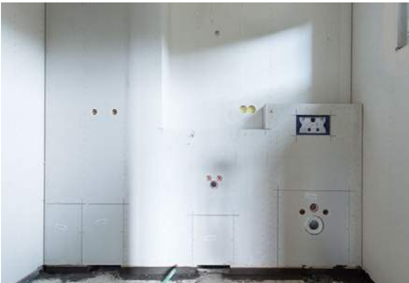
Tragständer für wandhängende WCs mit Einbauspülkästen
