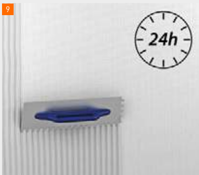
Aufbringen der zweiten Putzschicht 2–3 mm fermacell™ HD Leichtmörtel nach Erhärten der Armierungsschicht (Variante A)
