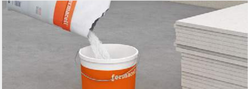
Einstreuen fermacell™ Fugenspachtel in sauberes Wasser, danach einsumpfen lassen
