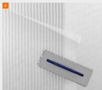
Überlappung des Armierungsgewebes mit ca. 100 mm
