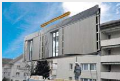
Krantransport auf der Baustelle
