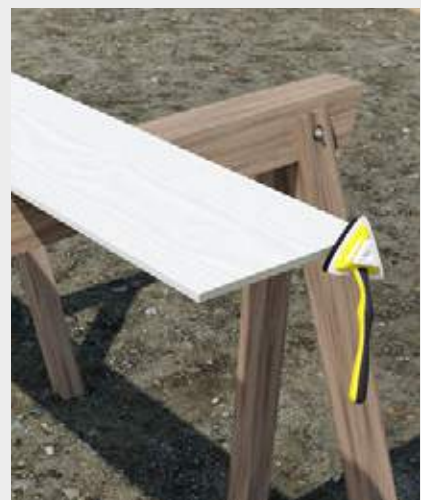
Auftragen der ColourPlus™ Kantenversiegelung vor der Montage.
