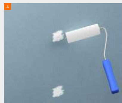
Deckendes Abtupfen der Verbindungsmittel in der Plattenfläche
