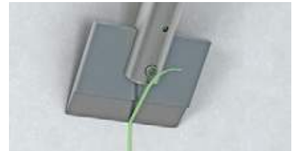
Entfernen des überschüssigen Klebers mit fermacell™ Klebstoffabstoßer
