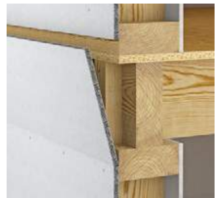
Bild 2: Montage des Plattenstreifens
