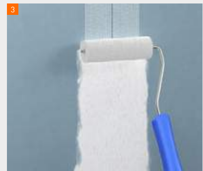
Aufrollen des fermacell™ Armierungsklebers HD
