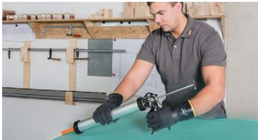
Aufbringen des fermacell™ Fugenklebers mit dem praktischen 580-ml-Folienbeutel
