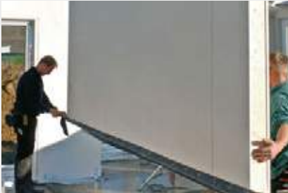
Positionieren, Ausrichten und Unterklotzen der Wandelemente
