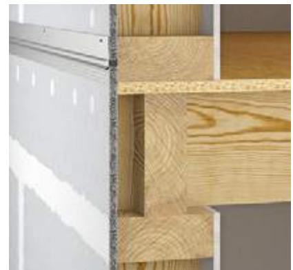
Bild 6: Fertig montierter Plattenstreifen mit fermacell™ Deckenstoßprofil
