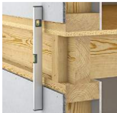
Bild 1: Ausrichten der Wandelemente
