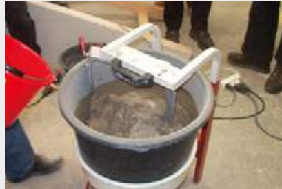
Anmischen fermacell™ Quellmörtel
