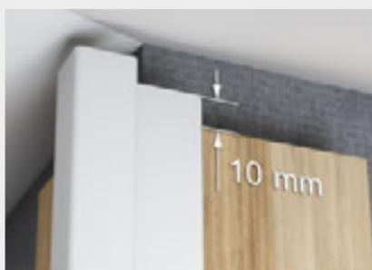
HardiePlank™ MetalTrim™ Zierleisten oben und unten 10 mm überstehen lassen.
