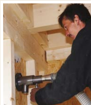
Zweischalige Außenwände werden häufig mittels Einblssystemen gedämmt. Mit einem Steinwolle-Granulat wie dem HR der Deutschen Rockwool können Dämmdicken von 50 bis 400 mm hohlraumfrei bis zu einer Länge von 2.500 mm pro Gefach erstellt werden.
