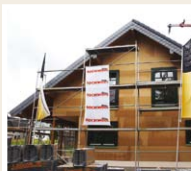
Ein privates Einfamilienhaus in Holzrahmenbauweise errichtete die Zimmerei A+S Klein GmbH im Monschauer Land südwestlich von Aachen. Zum ersten Mal dabei: die Einblasdämmung für Holzbauten aus Steinwolle-Granulat der Deutschen Rockwool.
