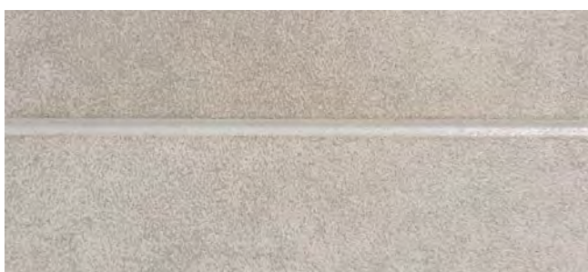
Schritt 3: Ergebnis ist eine hochflexibel gefüllte Fuge in Zementfugen-Optik
