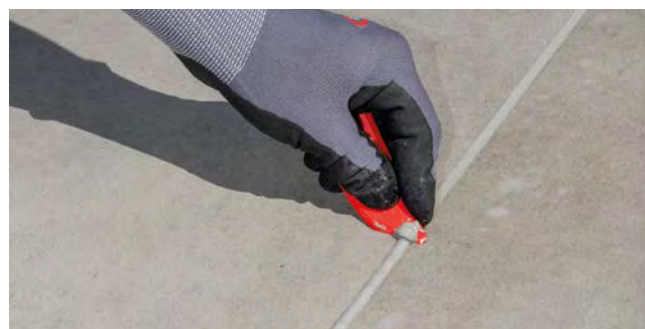
Schritt 2: Vor Einsetzen der Hautbildung mit Sopro Glättmittel befeuchten und einmal mit einem Silikonglätter glätten
