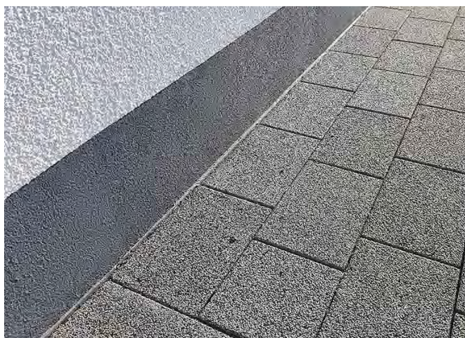
Schnittstelle zwischen Freifläche und Gebäude mit PLEXBAND
