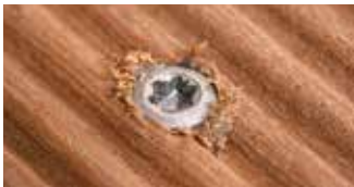
Belagschraube ohne Vorbohren
